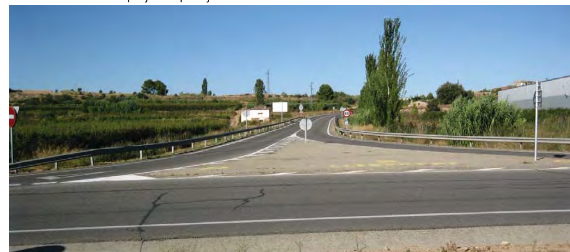
Carretera C-233 i C-73 a l'inici de la mateixa a poca distància de la zona del projecte
