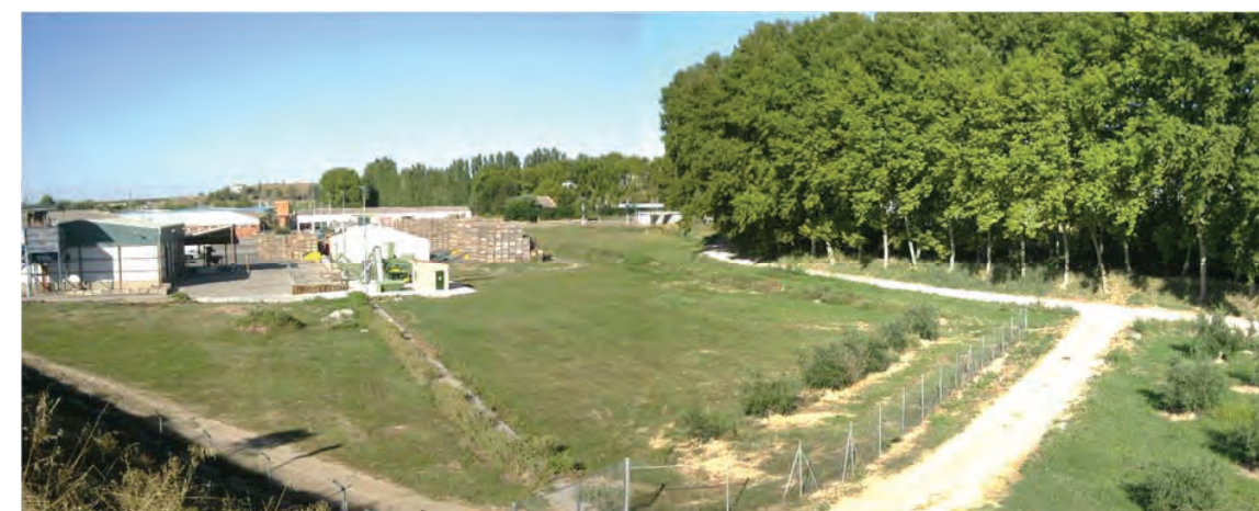
Visual del sector des de la carretera N-240
